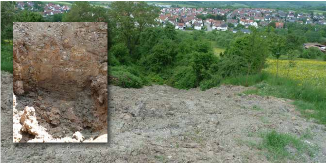
Verwendung von ungeeignetem Bodenmaterial, Auffüllung mit Verdichtung als schädliche Bodenveränderung
