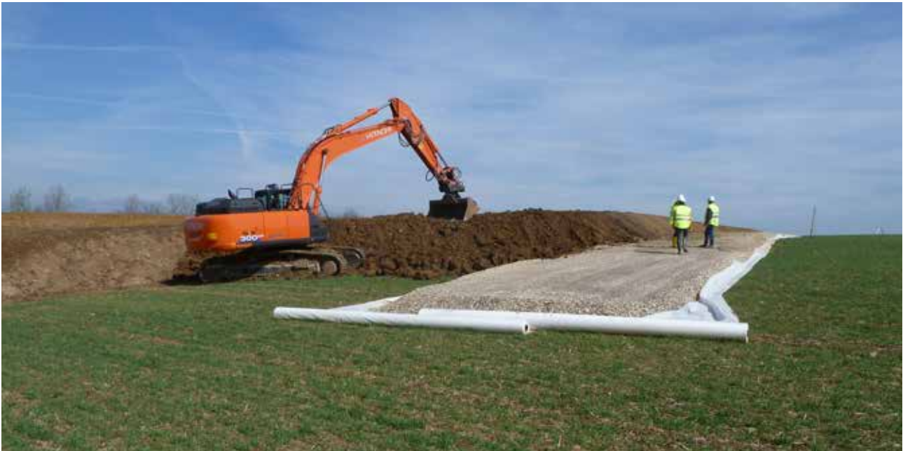
Fachlich korrektes Erstellen der Oberbodenmiete mit Baustraße zur Anlieferung
