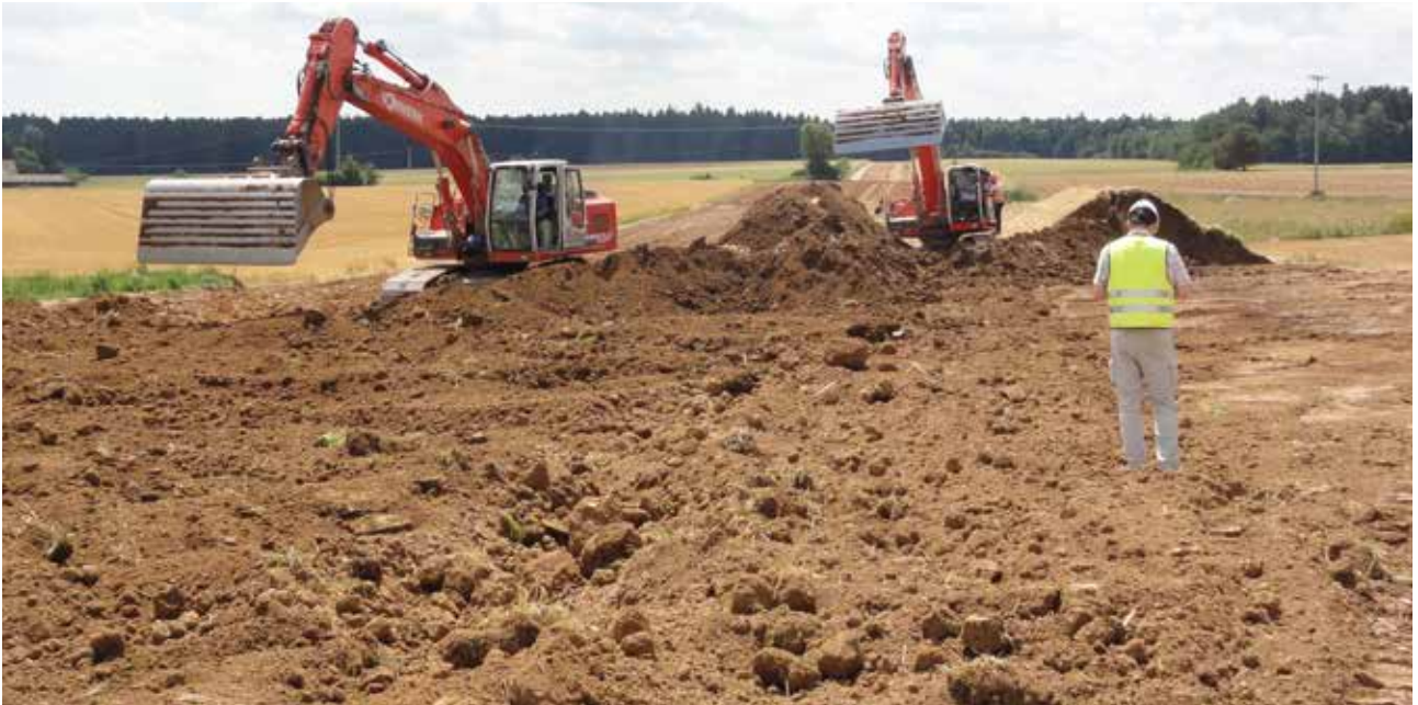
Bodenauftrag mit bodenkundlicher Baubegleitung
