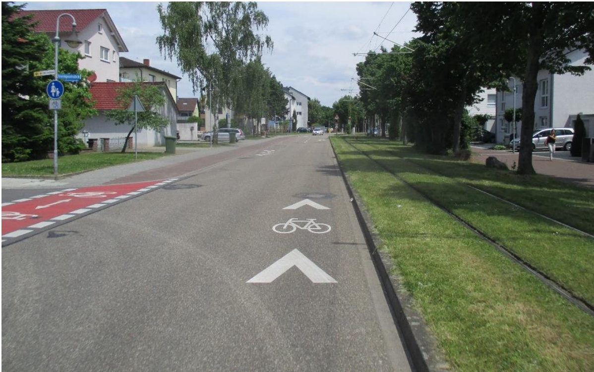
Abbildung 26 – Karlsruher Straße in Rheinstetten; Foto: VAR+ ©
